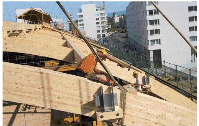
Das Dach der Halle wurde rekonstruiert. Bild: Roger Suter
