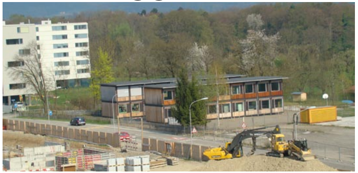
Zurzeit stehen an der Mühlackerstrasse zwei Pavillons.
