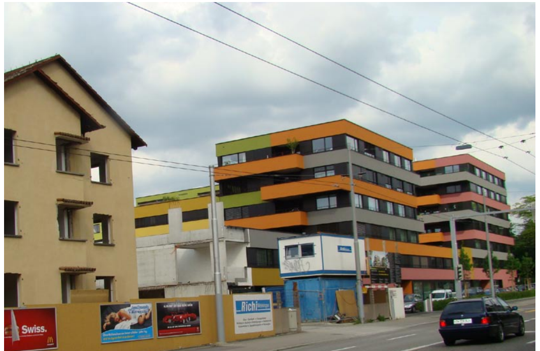
Die farbigen Blöcke der Baugenossenschaft Frohheim fallen auf.
