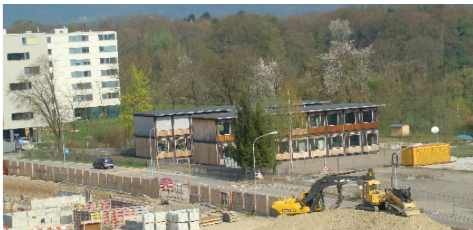
Zurzeit stehen an der Mühlackerstrasse fünf Pavillons.
